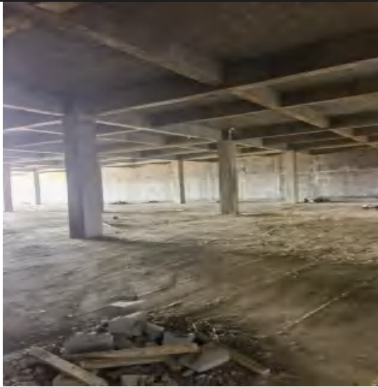
在建门诊医技楼三层 DSA 机房位置
